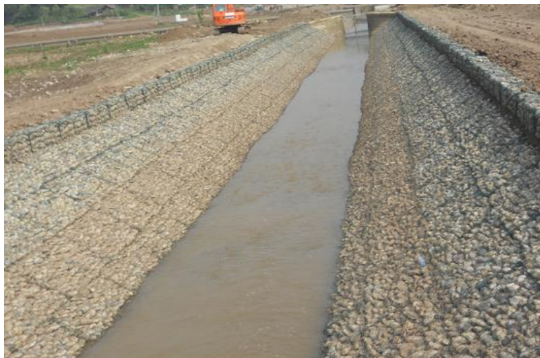
图 2-2 格宾石笼施工
