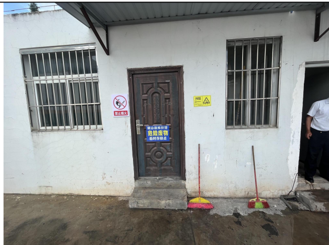
现有工程已建危废暂存间
