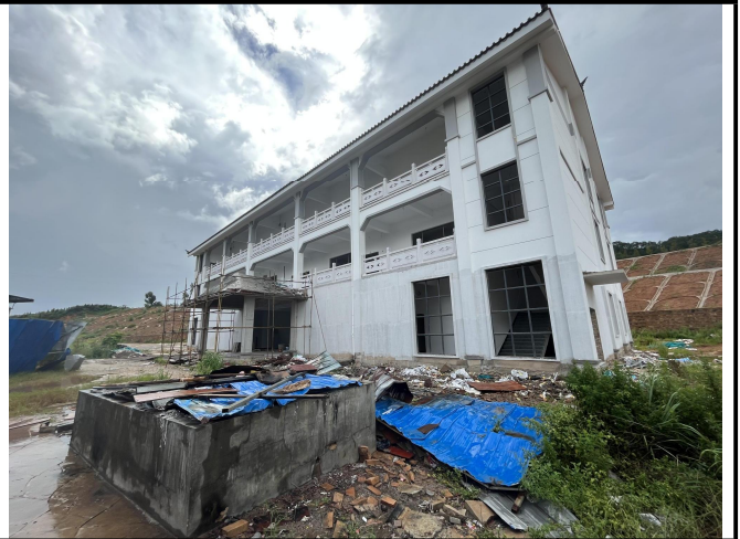
急冷废水回水池
