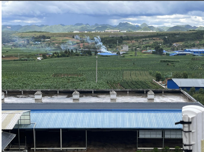
殡仪馆东侧环境现状
