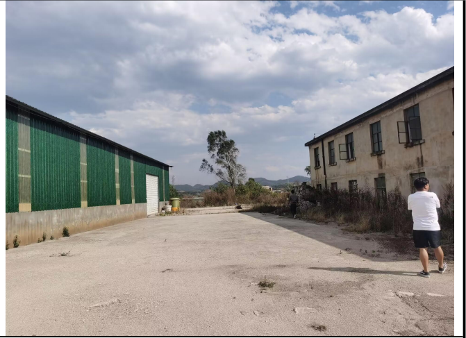
现有构筑物现状
