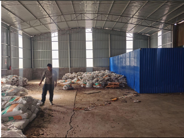
现有钢架结构厂房内部现状
