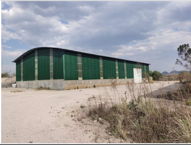
厂区现有钢架结构厂房现状
